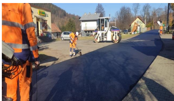
Remont drogi powiatowej w Koszarawie
