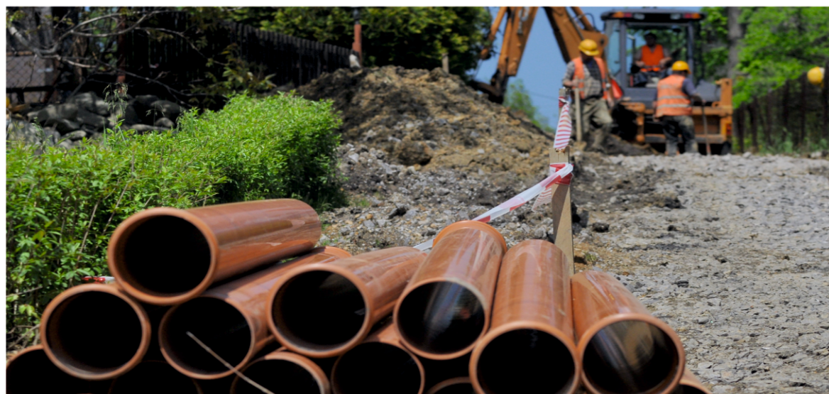
PROJEKT „OCZYSZCZANIE ŚCIEKÓW NA ŻYWIECCZYŹNIE” – DLA LUDZI I ŚRODOWISKA
