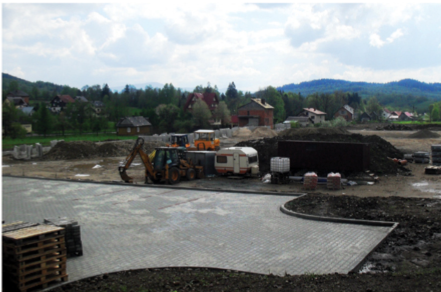
plac budowy boiska sportowego w Koszarawie Cichej
