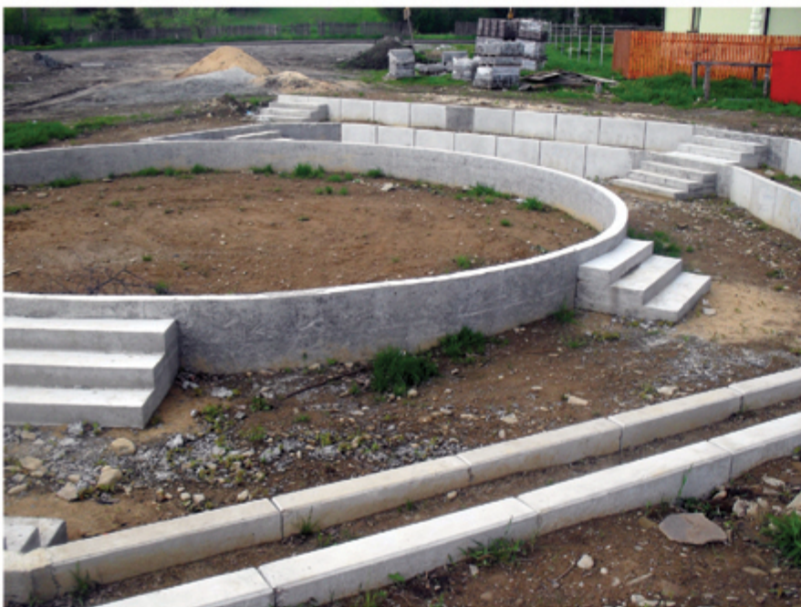
plac budowy amfiteatru w Koszarawie
